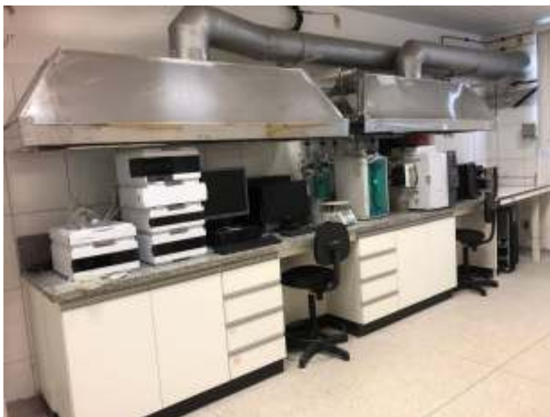
Figura 2 - Sistema de exaustão com os cromatógrafos líquido, de íons e gasoso, respectivamente, da esquerda para direita.
