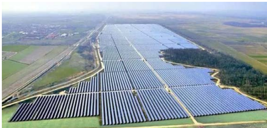
Figura 5 - Maior Usina Fotovoltaica do Brasil, localizada na cidade de São Gonçalo do Gurguéia, no Piauí [10]
